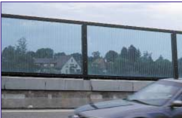
Gauche: paroi recouverte près de Rancate, bandes verticales (5 mm de large, écart 5 cm) sur un viaduc près de Berne. Droite: les idées ne manquent pas, mais l'efficacité de telles mesures n'a nulle part été vérifiée.
