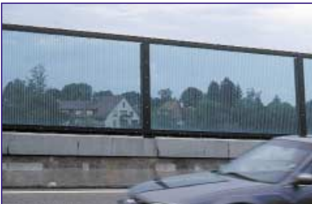
Links: Überdeckte Wand bei Rancate, vertikale Streifen (5 mm breit, 5 cm Abstand) auf Viadukt bei Bern. Rechts: Ideen gibt es viele, doch die Wirksamkeit solcher Massnahmen wurde nirgends geprüft.
